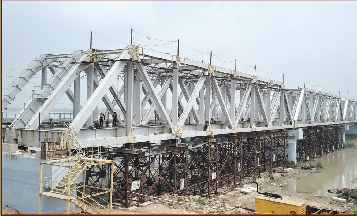
बलिया-छपरा रेलवे दोहरीकरण परियोजना के तहत घाघरा नदी पर पुल संख्या 16 का निर्माण कार्य प्रगति पर है। Construction of Bridge No.16 over Ghaghra river of Ballia-Chhapra Railway Doubling project is in progress.
